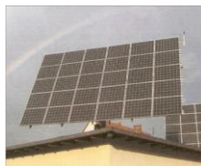
Slika 2. Fotonaponski panel sa mogućnošću praćenja pozicije Sunca [1]
